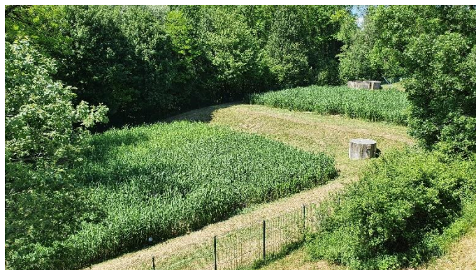
Figure 5 : La qualité du rejet des stations à macrophytes est remise en cause – Unité de traitement de Minzier
