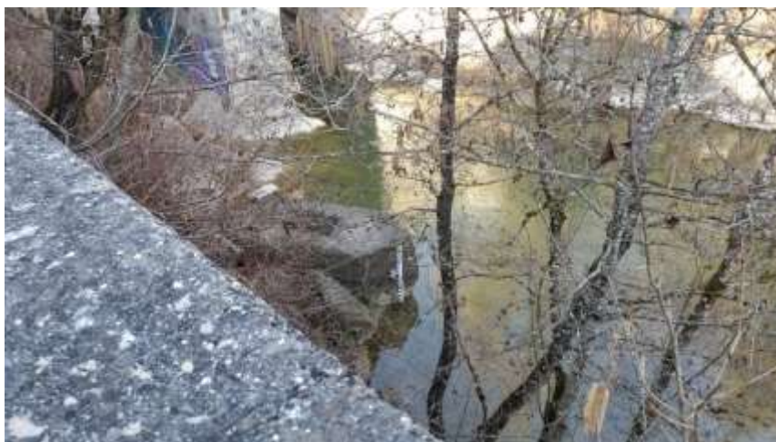
Figure 2 : Echelle de mesure des hauteurs d'eau au niveau de la station du pont des Douattes
