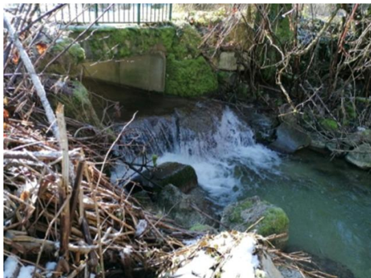
Les Petites Usses, ouvrage du pont de l'ancienne STEP ROE 55 959
