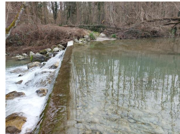
Le Fornant, ouvrage conduite AEP/passage à gué ROE 24 396
