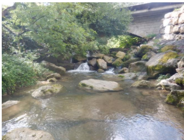
Les Petites Usses, ouvrage de la RD1508 ROE 24 397
