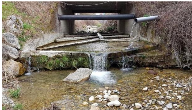
Le Castran, ouvrage Pont route du Tram ROE 24385 liste 1
