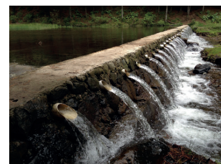
Photo 9 : Construction d'un muret pour maintenir une hauteur d'eau artificiellement
