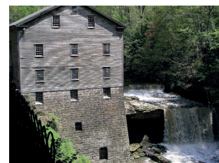
Photo 7 : Aménagement de retenue d'eau pour le fonctionnement des usines
