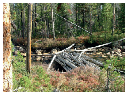
Photo 4 : Embâcle de bois mort sur la rivière
