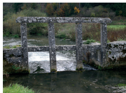
Photo 1 : Ancien seuil à usage non déterminé (peut-être : régulation du niveau de l'eau)
