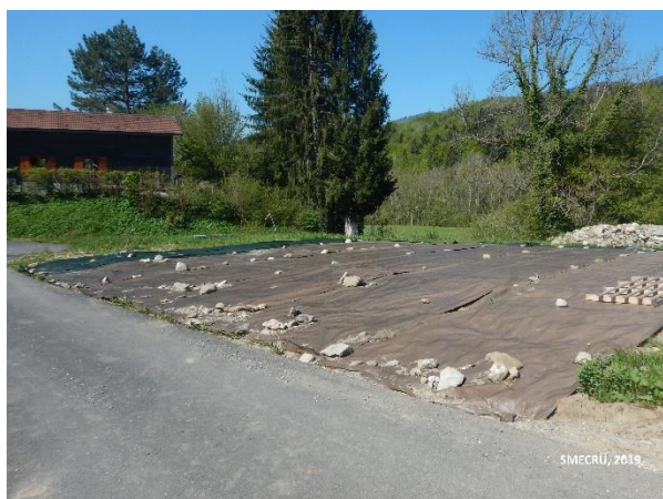
Surface traitée et bâchée
